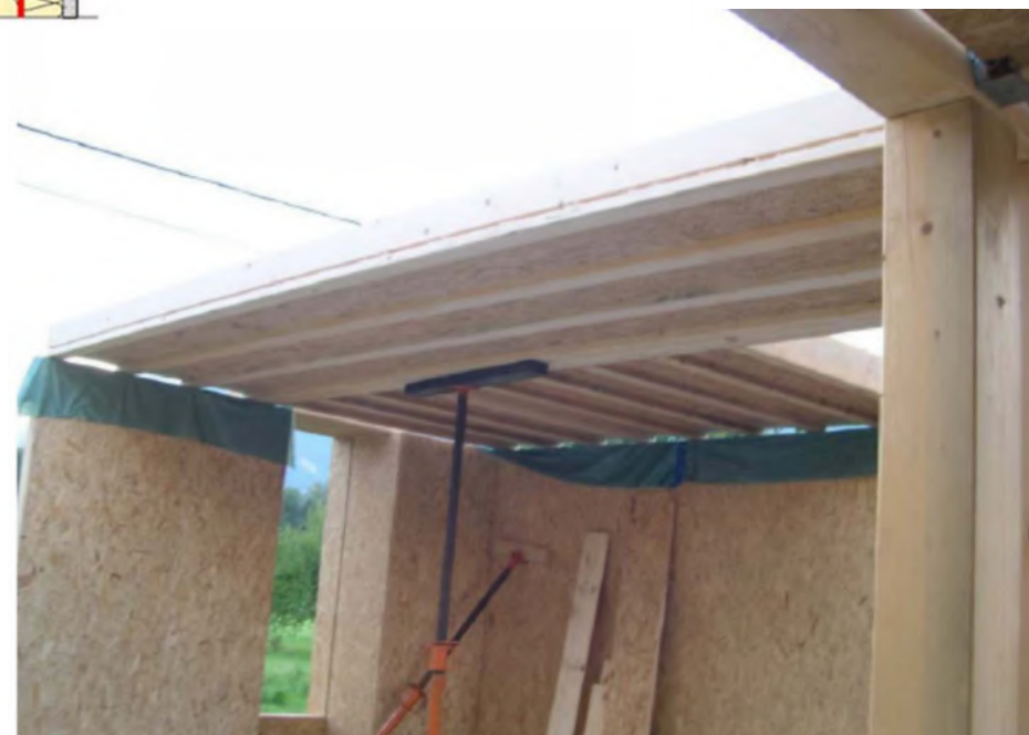
Coupe Verticale – Jonction entre façade et plancher bois
