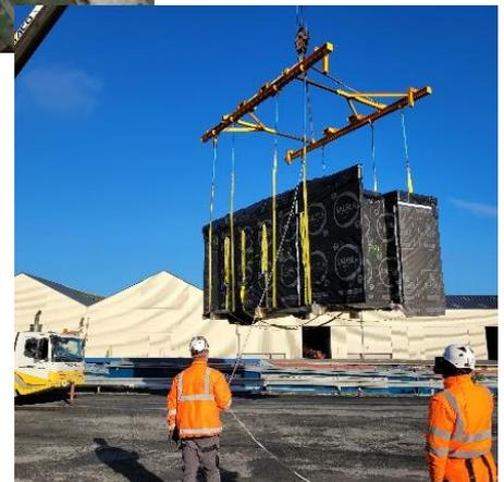
Du côté de la réception sur le chantier de l'île Saint Denis – immeuble PE2 - les modules ont été déchargés avec une grue à tour calibrée pour survoler le plan d'eau où Voies Navigables de France avaient installé, au préalable du chantier global du quartier, quatre duc-d'albe et une passerelle permettant l'accostage des bateaux.
