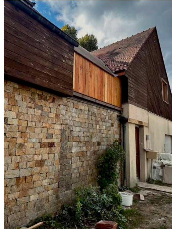
MAISON MYOSOTIS (91) Architecte : Atelier Sajúma - Matilde Julia Saravia
