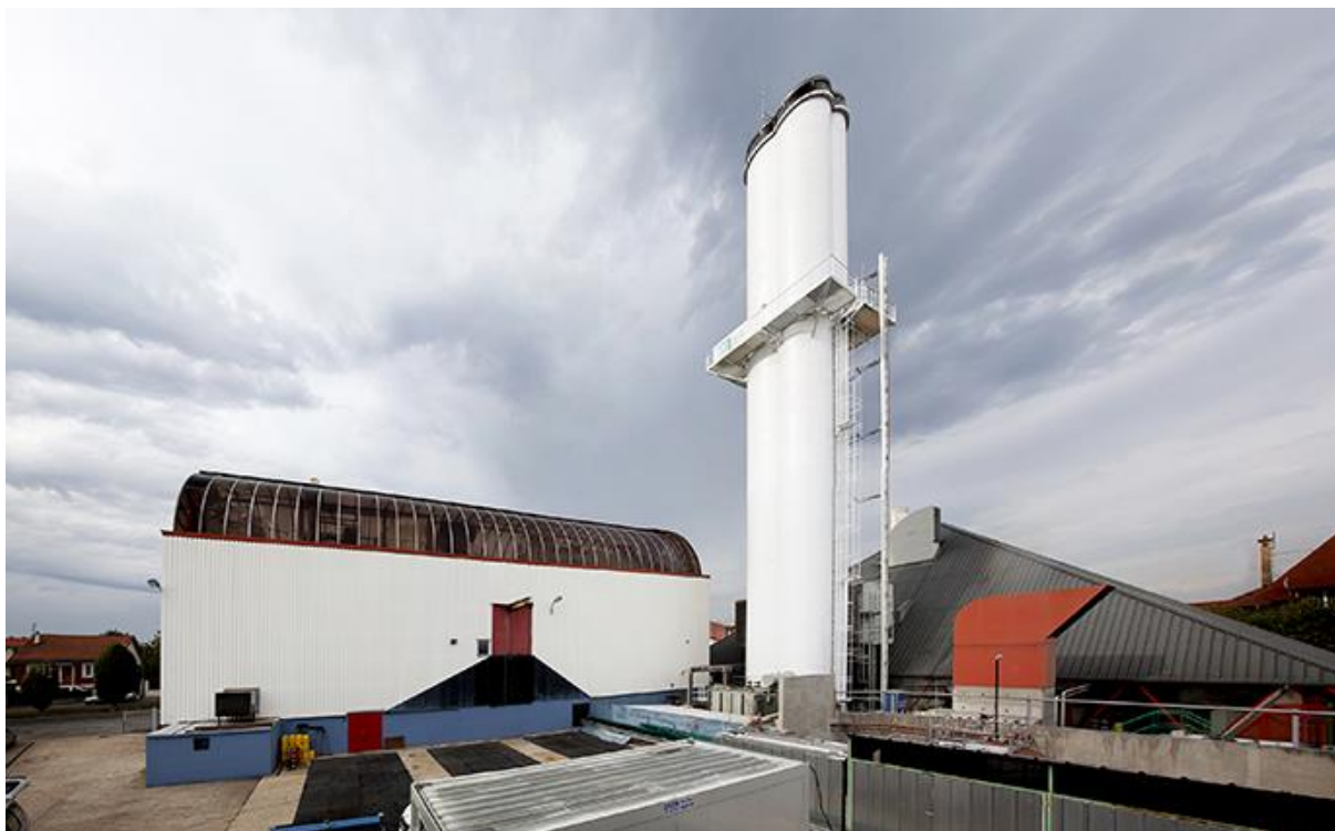
Chaufferie centrale de Fontenay-sous-Bois © La Régie du Chauffage Urbain
