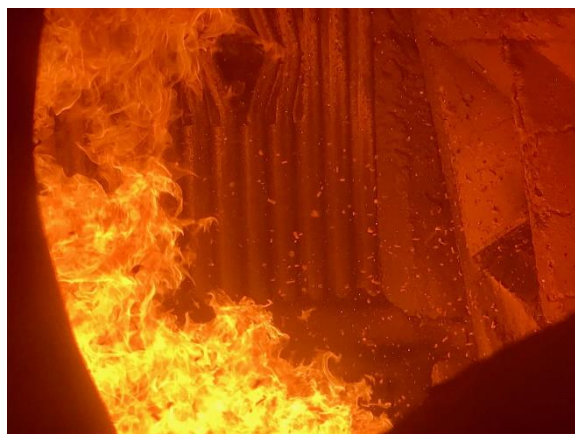
Flamme du foyer de la chaudière biomasse © Régie du Chauffage Urbain
