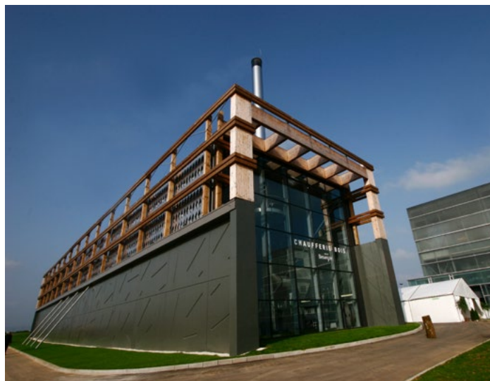
Chaufferie collective bois Besançon - Crédit Christian Weiss - ADEME.
